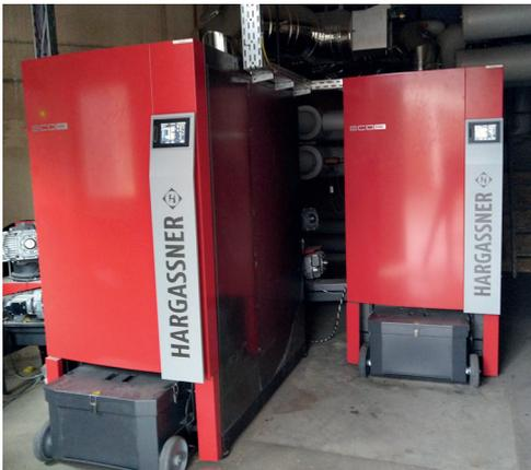
Die beiden 200-Kilowatt-Hackschnitzelkessel der Firma Frank Bürsten (Foto: Frank Bürsten GmbH)
